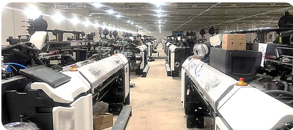
ماشین آلات بافندگی در حال نصب و راه اندازی
