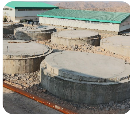
فونداسیون مخازن استیل مایع سازی، تخمیر، تغلیظ و جداسازی
