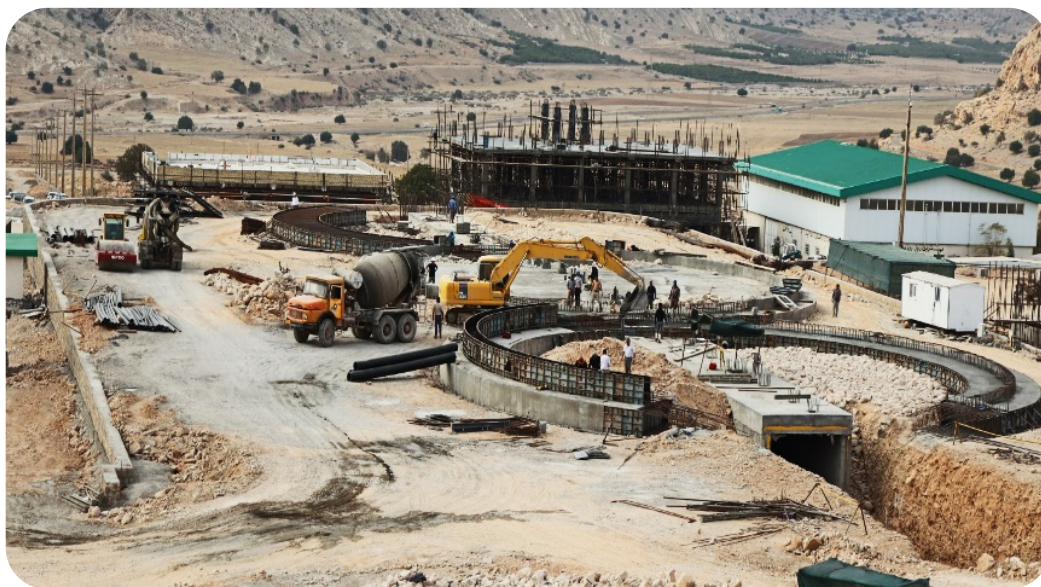
اجرای عملیات ساخت مخازن ذخیره بیواتانول
