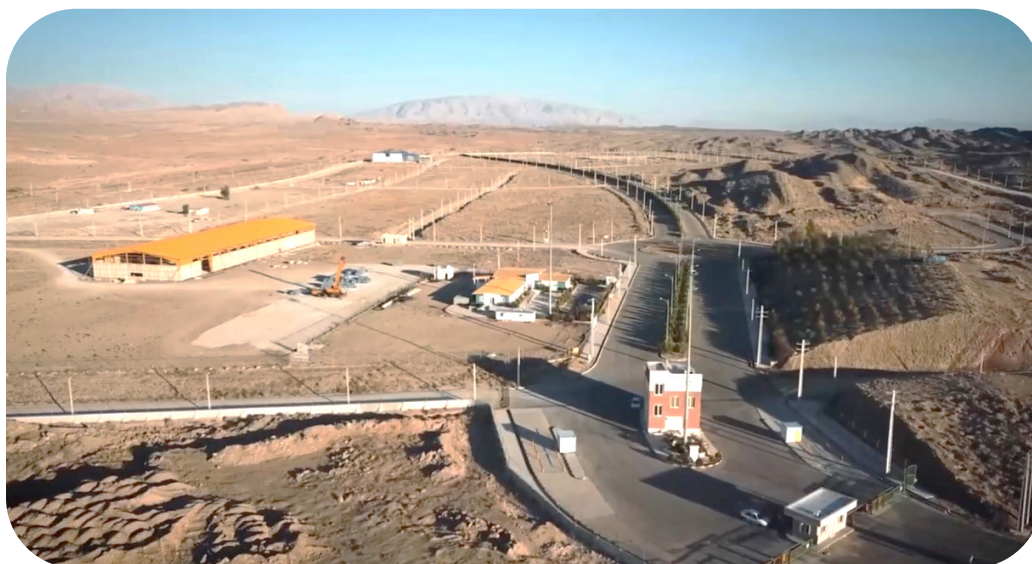
نمای ساختمان اداری و گمرک منطقه
