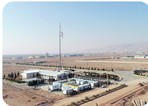
نمای ساختمان اداری و گمرک منطقه
